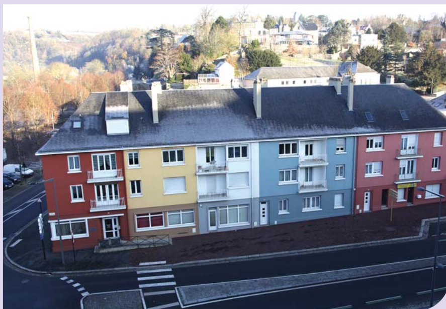
Parées de teintes lumineuses, les façades des immeubles de la rue de la Poterne, à Saint-Lô, ont remis en valeur tout un quartier à l'architecture typique de l'après-guerre. Une vaste opération de colorisation, engagée par la ville pour redynamiser son centre.
